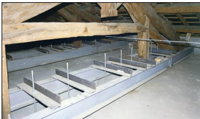
Solaio ligneo quattrocentesco: intervento nascosto di rinforzo
