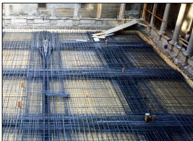
Disegno di progetto ed armature del cortile del settecento (Università di Milano, Sede centrale)
