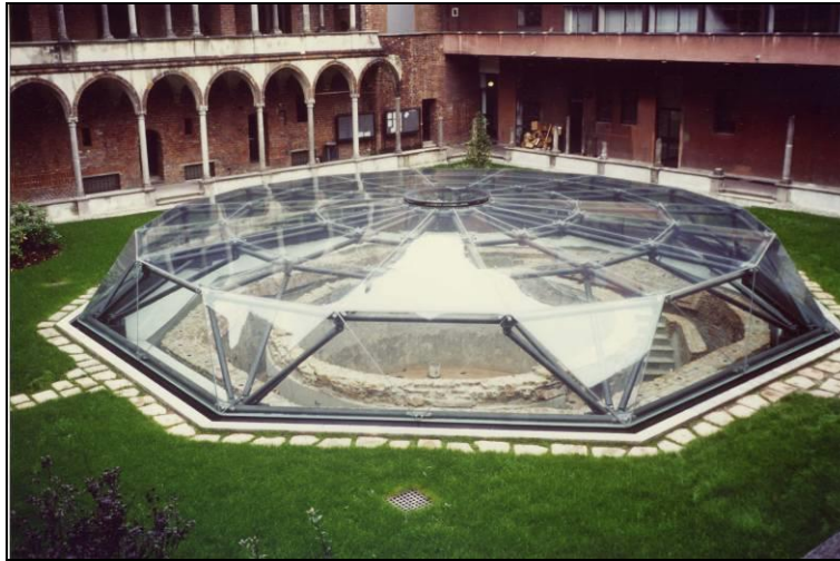
La cupola della Ca' Granda in acciaio e vetro strutturale
