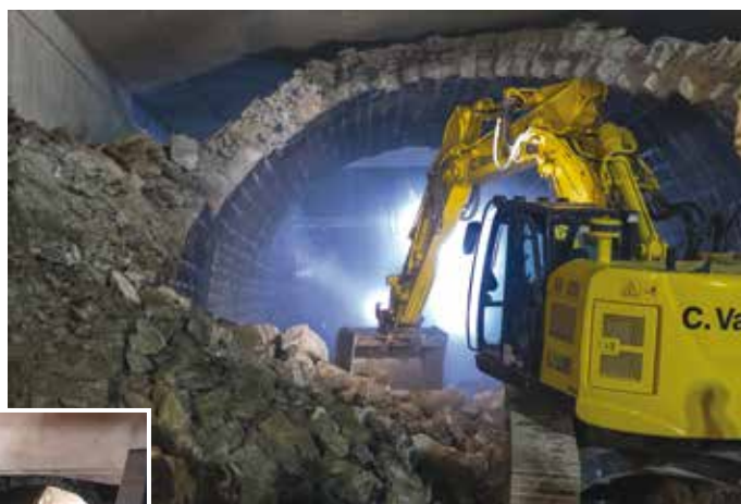
9A e 9B. La demolizione della galleria esistente
