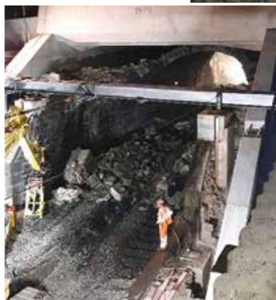
9A e 9B. La demolizione della galleria esistente
