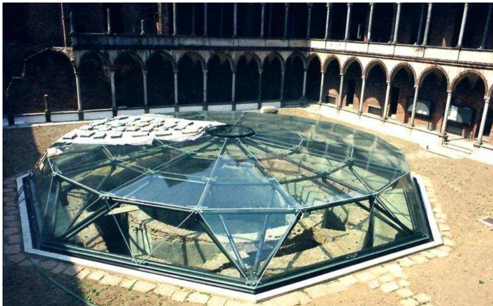
Collaudo: prova di carico dei cristalli di copertura
