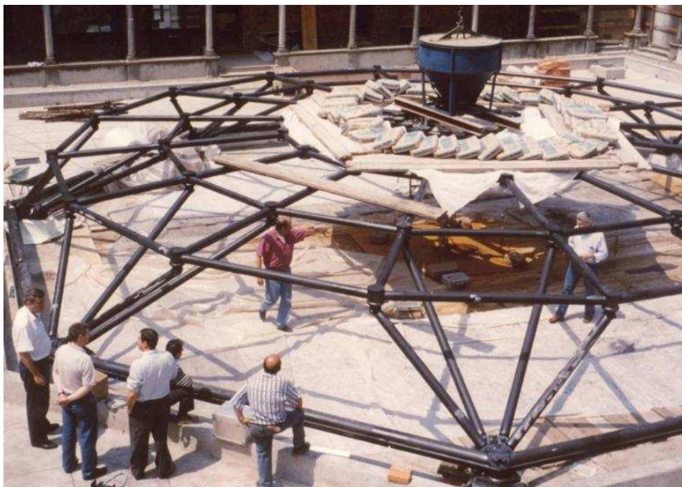
Collaudo: Prova di carico sulla struttura in acciaio
