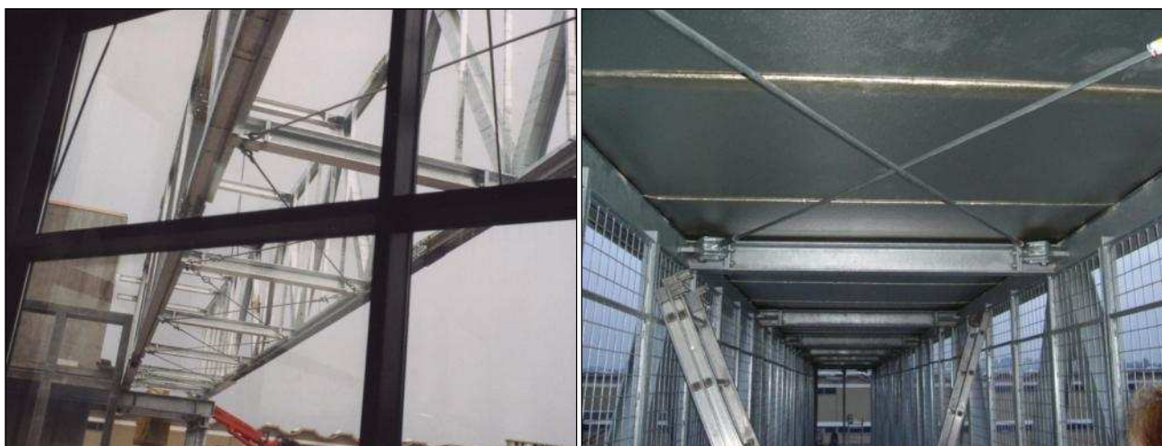
Vista del ponte e sistema di controventatura di irrigidimento
