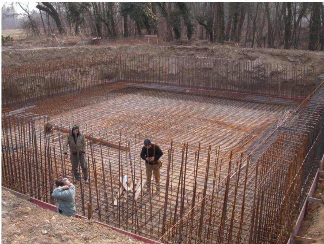
Posa dell'armatura nella parte inferiore delle pareti
