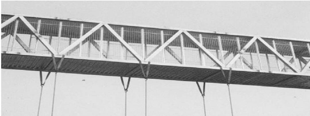
Collaudo del ponte pedonale mediante tiranti e martinetti
