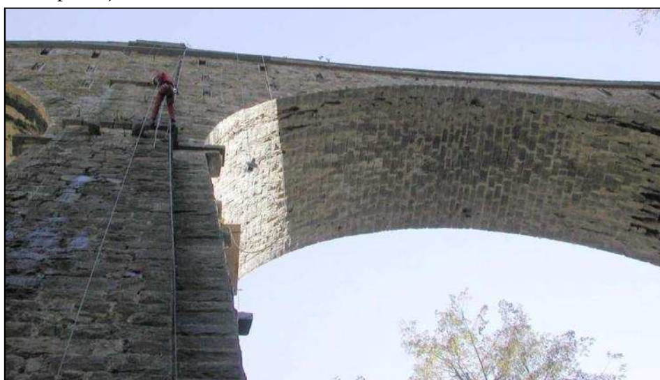
Posizionamento di apparecchiature di misura ad opera di rocciatori
